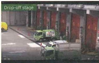
西宮市ごみ焼却施設
